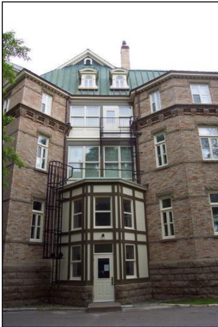
Entrée et mur du côté ouest avant les travaux
