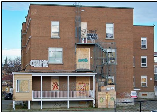
La Résidence Lionel-Roy a plusieurs vitres cassées et toutes ouvertures condamnées. Photographie : Yves-Marie Mélançon.
