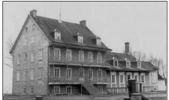
Adossé au fleuve et de gauche à droite : le « futur » évêché, le vieux presbytère d'accueil avec, à sa droite, l'édicule qui servait de chapelle. Photographie : L.O. Vallée. AAR.
