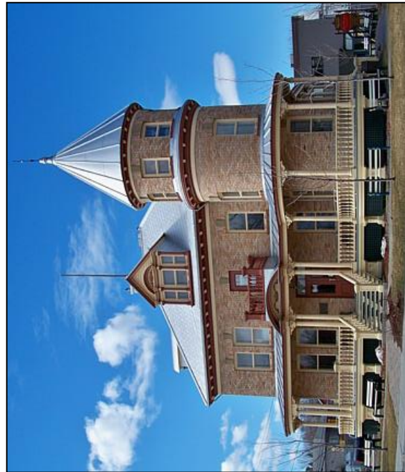
Maison Gauvreau, 1 rue de l'Évêché Ouest
