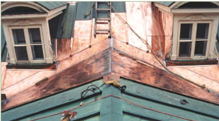
Réfection d'une partie de la toiture
