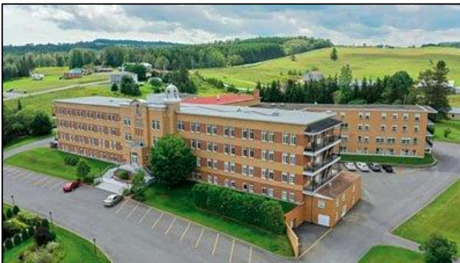
Facade de la maison mère des Servantes de Notre-Dame, Reine du clergé.
