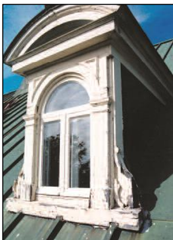
Lucarne avant les travaux
