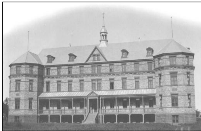
L'archevêché, nouvelle résidence épiscopale, en 1903. Photographie inconnu. AAR.
