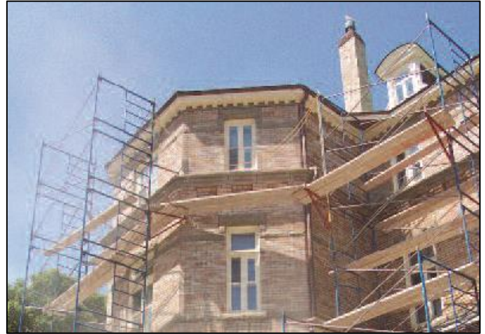
Évidement des joints de maçonnerie
