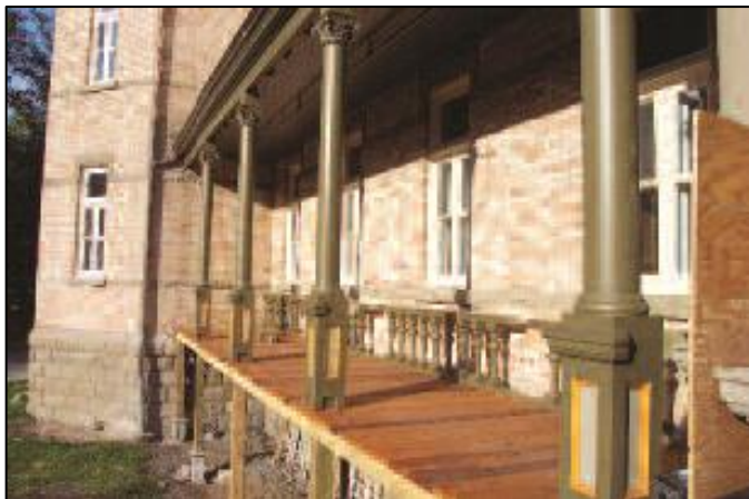
Restauration de la galerie avant
