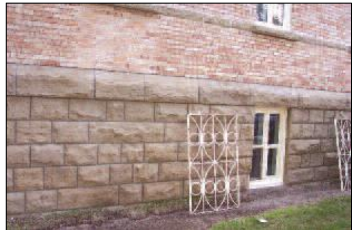
Le rejointoiement de la maçonnerie est terminé
