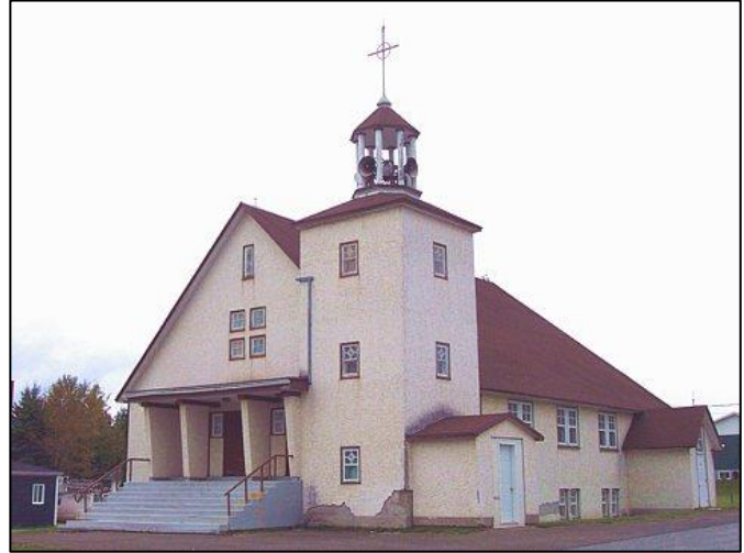
Église de Saint-Alexandre-des-Lacs. Photo : Yves-Marie Mélançon.
