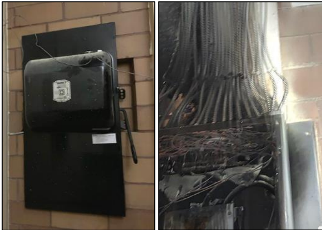
À droite et à l'origine de l'incendie, une boîte comme celle de gauche, mais encastrée dans le mur de la Pourvoirie d'autrefois. Photos : Bertrand Laplante.
