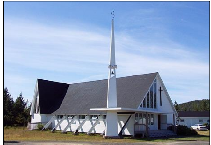
La chapelle de la « colonie de vacances », une œuvre de l'architecte Gaston Martin (lui-même un ancien campeur). Photographie : Yves-Marie Mélançon.
